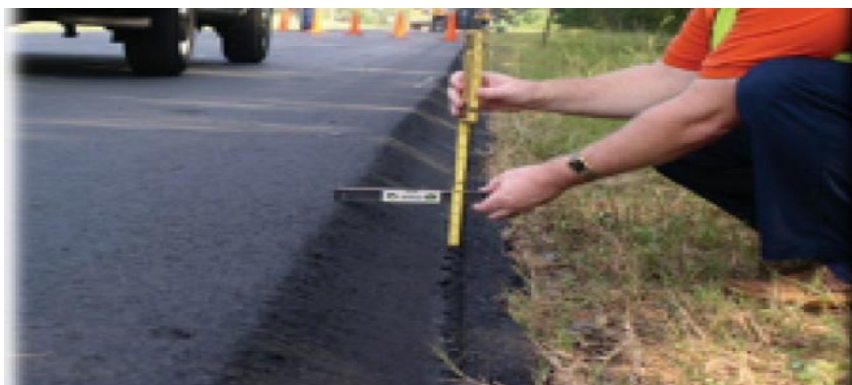
Рисунок 2 – Измерение толщины слоя по кромке
